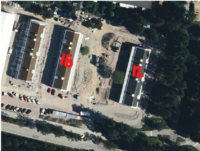
Figur 6. Flygfoto av bostadshusen under ombyggnadstiden, källa www.hitta.se
